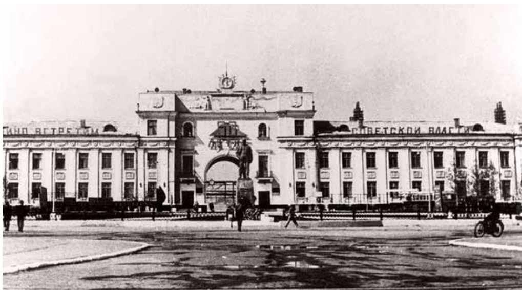
Фото. Заводоуправление Салаватского нефтехимического комбината № 18, 1950-е гг. Источник: https://salavat-neftekhim.gazprom.ru/press/gallery/2/
