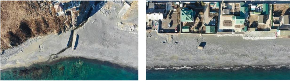
Рис. 3. Преобразование пляжа при искусственной берегозащите в пос. Зарубино. Слева – укрепление устья водотока, справа – защита жилых построек. *Фото Д.А. Соловьева*
