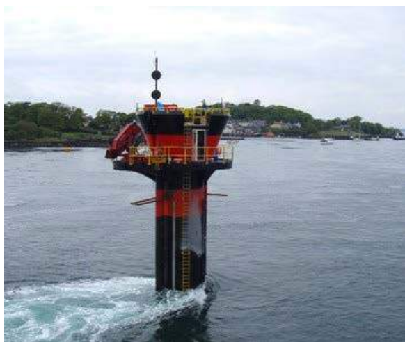
Рис. 1. SeaGen – первая промышленная электростанция, использующая кинетическую энергию приливных течений, Северная Ирландия. Фото: [12, 14 мая 2008].
