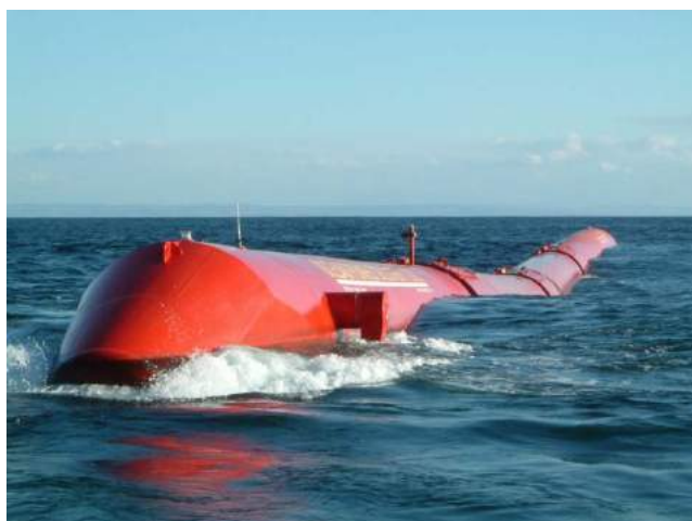
Рис. 3. Испытания волновой электростанции фирмы Pelamis Wave Power у побережья Шотландии. Станция состоит из 4 секций диаметром 3,5 м, ее суммарная длина составляет 140 м. Фото: Pelamis Wave Power
